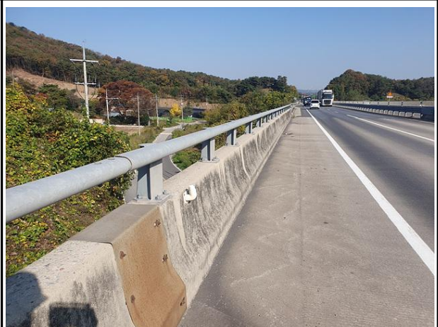
난간 및 연석 전경
