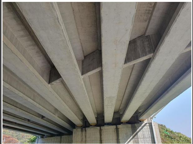
거더 및 가로보 전경
